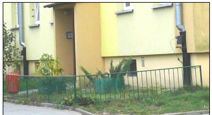
Foto 4 ó Przykładowe odsadzki na rurach spustowych
