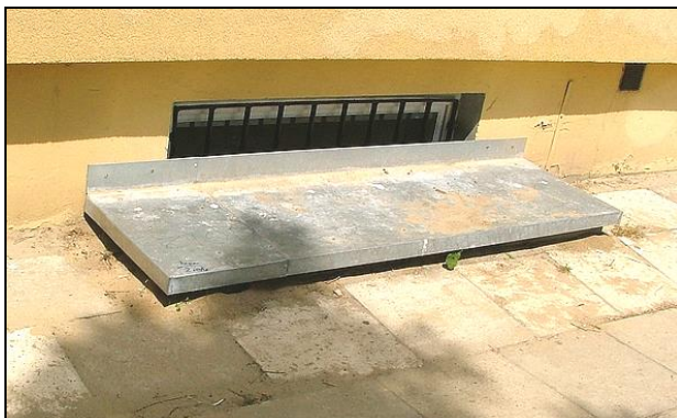
Foto 3 ó Przykładowe okienko piwniczne
