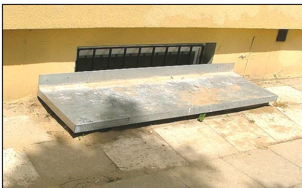
Foto 3 ó Przykładowe okienko piwniczne
