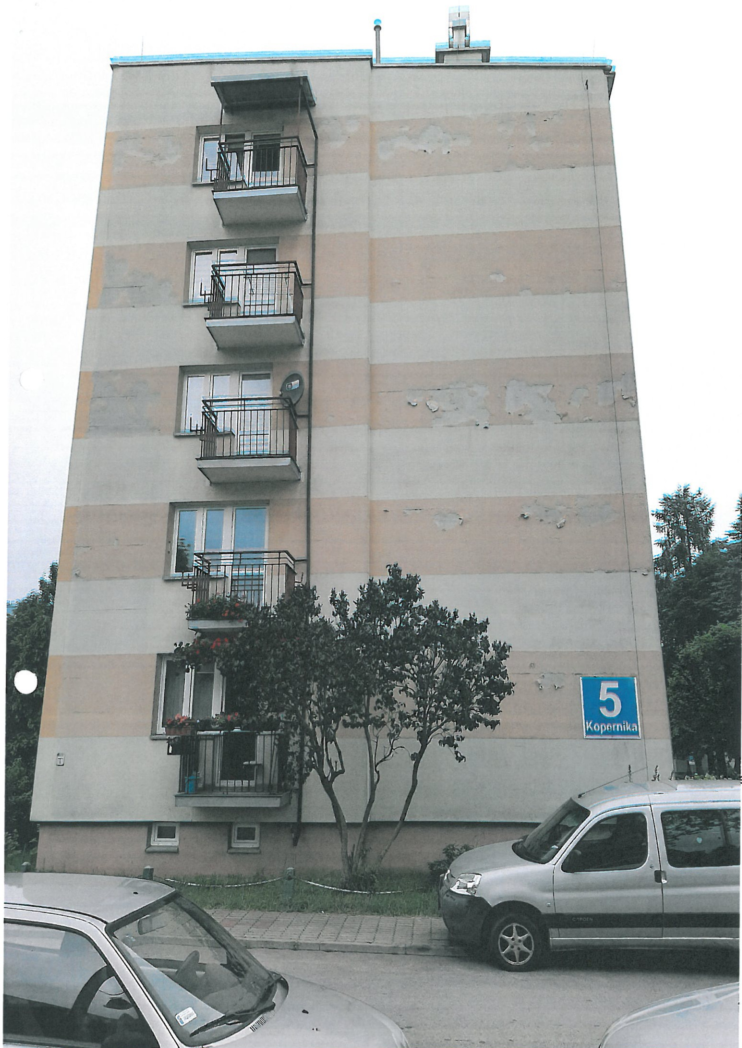
Widok elewacji do remontu
