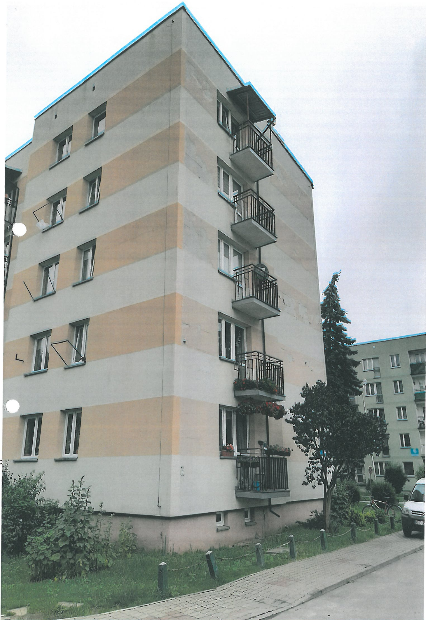
Widok elewacji do remontu
