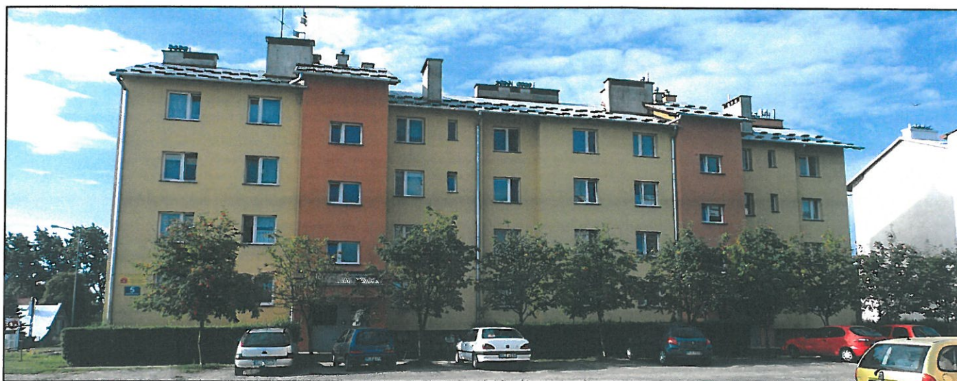
Foto 1 - Elewacja frontowa północna
